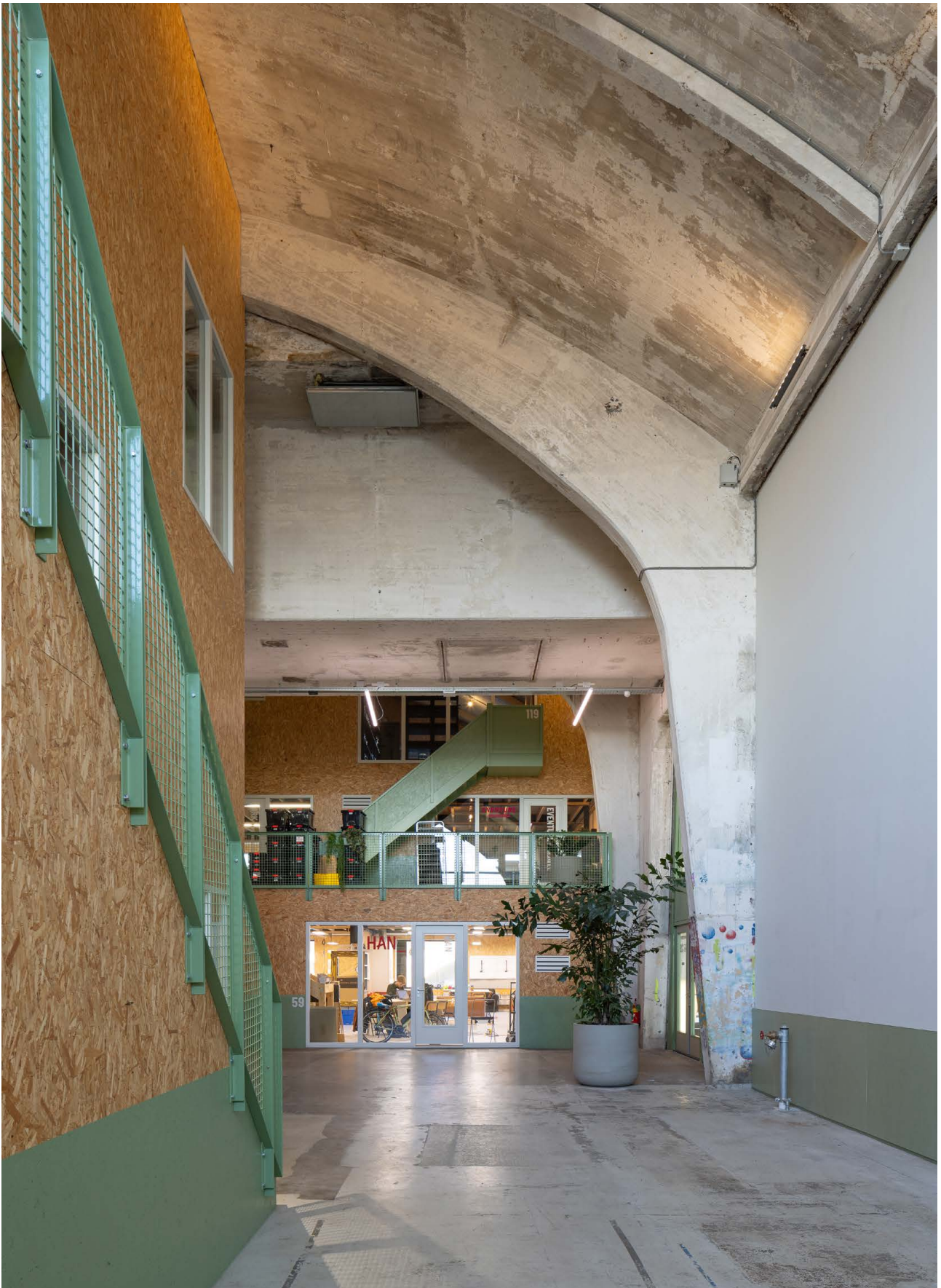
De nieuwe houten volumes in de Werkstad in contrast met de bestaande betonconstructie en centrale as met installatiegang
