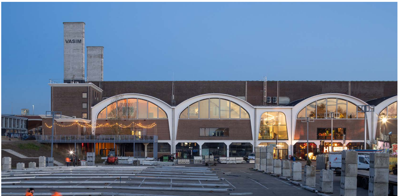
De westgevel van De Vasim gezien vanuit de grote kolk met nieuwe gevelopeningen en verhoogd terras aan dijk
