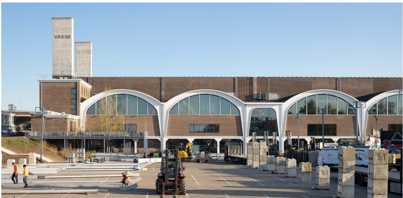
De westgevel van De Vasim gezien vanuit de Grote Kolk met nieuwe gevelopeningen en verhoogd terras aan dijk
