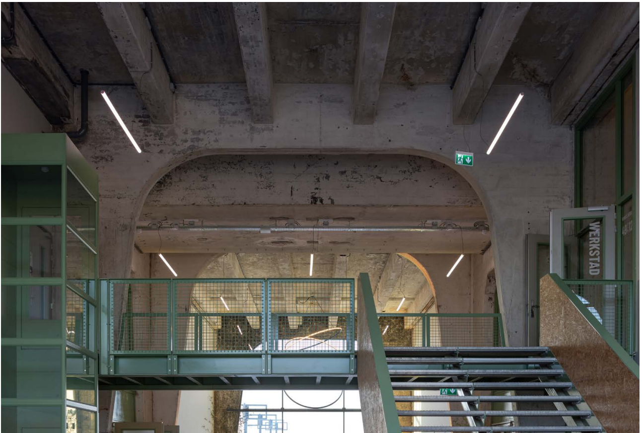
De brug in de centrale as met entree naar de Werkstad en zicht op de bestaande betonconstructie & installatiegang
