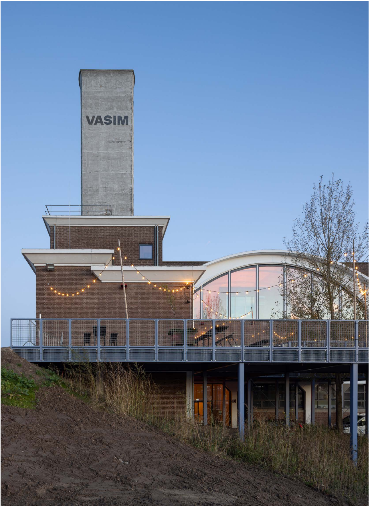
Het verhoogde terras van de horeca aan het transformatorhuis op dijkniveau
