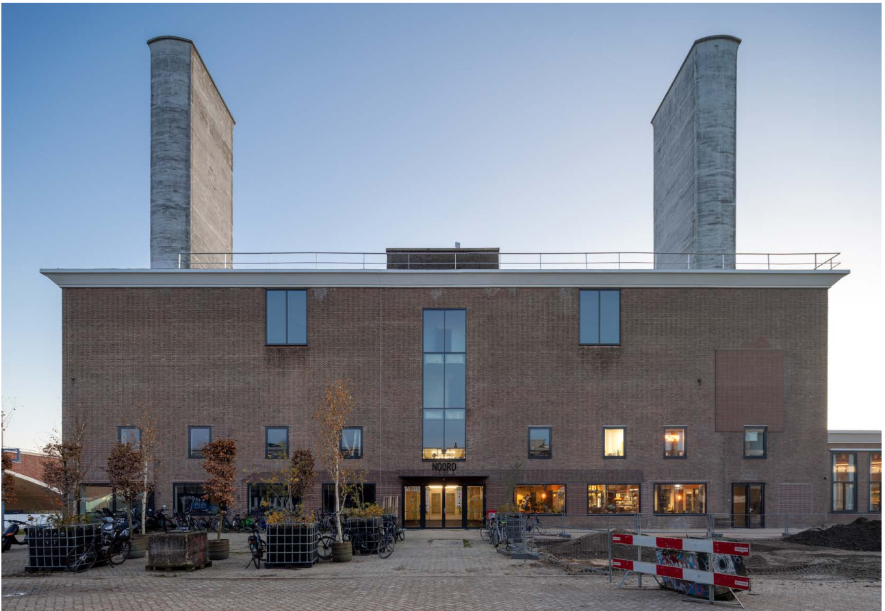
Het kopgebouw aan de dijk met nieuwe hoofdentree naar centrale as en nieuwe ontwikkelingen
