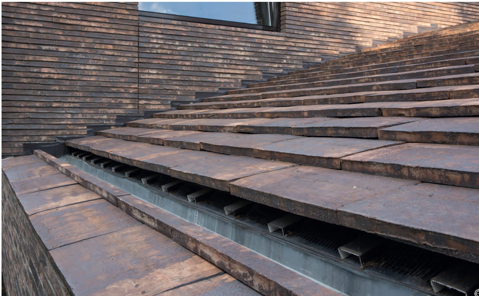
Om de verholen goot weg te werken, is een smal randje dakstenen op de onderliggende pan gelijmd. Voor de aansluiting met het opgaande werk is bruin gepigmenteerd lood gebruikt.
